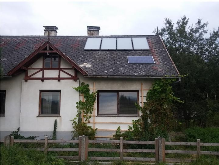
*Anordnung des PV-Moduls unterhalb der Solarthermie-Flachkollektoren.*
